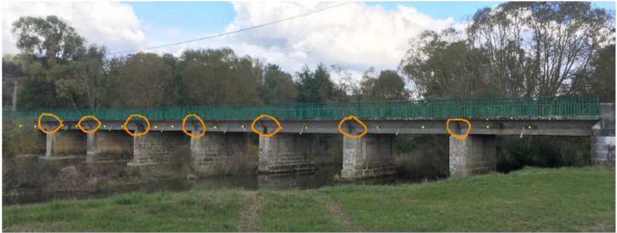
Localisation des barbacanes (points jaunes) et des joints de dilation (ronds oranges) conservés pour les chauves-souris
